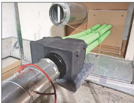
Imágenes 3 y 4 Detalles de la caja de distribución de foam y de su instalación
