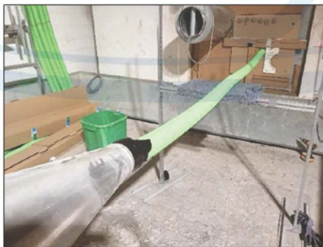
Imagen 7 Detalles de la instalación del tubo corrugado Ø75
